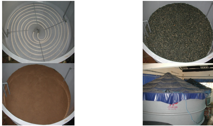
Hình 1: Thiết kế hệ thống bể lọc tuần hoàn nuôi tôm bố mẹ (ống dây của hệ thống sục khí kéo nước (trên-trái); lớp lọc bằng đá 1-2 cm (trên-phải); lớp cát mịn phủ trên lớp đá (dưới-trái) và bể đang nuôi được đậy kín (dưới phải)
